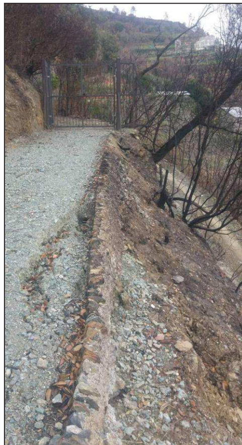
Foto 5: dettaglio del cordolo sottoescavato e progressivo coinvolgimento della carreggiata
