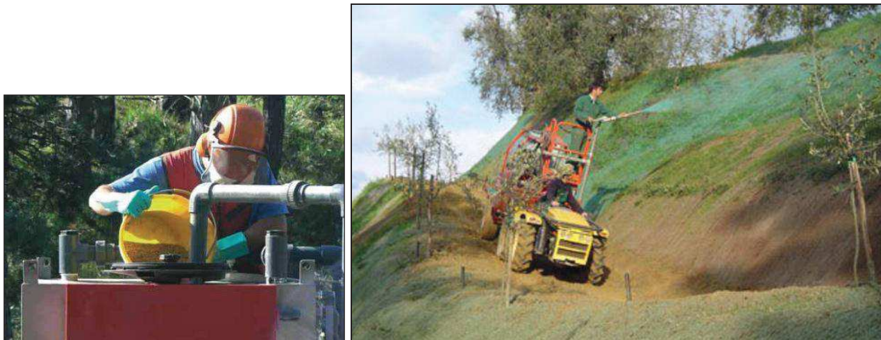
Foto 13: caricamento dell'idrosemiatrice e idrosemina su scarpata
