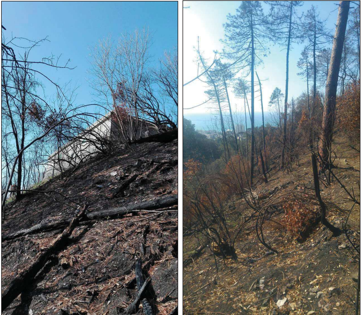
Foto 4: limite sud dell'area d'intervento. Particolare del versante bruciato in corrispondenza della vasca di accumulo dell'acquedotto.
