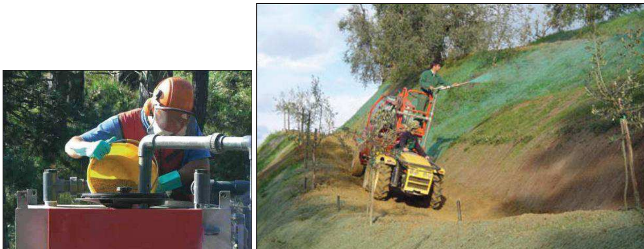
Foto 10: caricamento dell'idroseminatrice e idrosemina su scarpata
