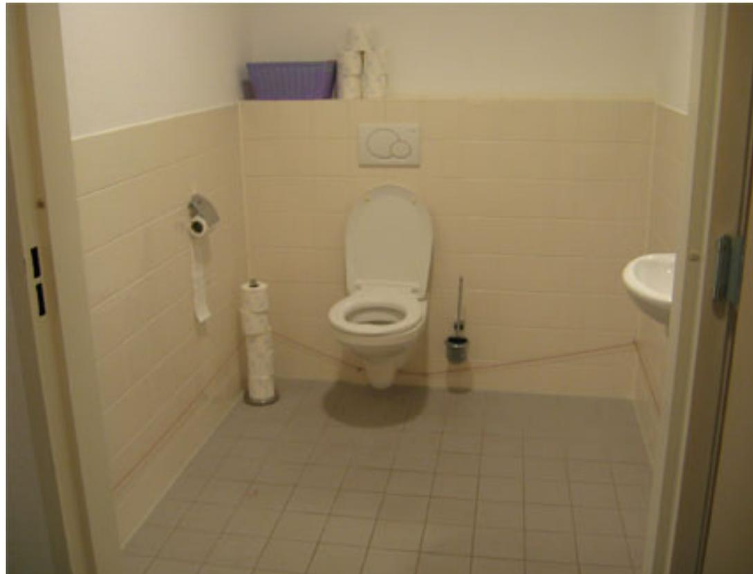
**Il campanello d'allarme nel progetto Navarea in Olanda** In questo caso il campanello di allarme è costituito da cordino calato da scatola posta a parete che giunge fino a 30 cm. dal pavimento. L'idea progettuale da segnalare è dovuta alla particolarità montaggio: il cordino è disposto lungo tutto il perimetro del bagno, fissato alle pareti con anelli .
